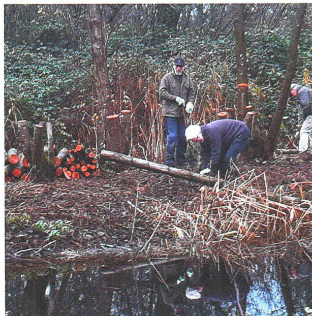
Werkzaamheden op de elzenkade
